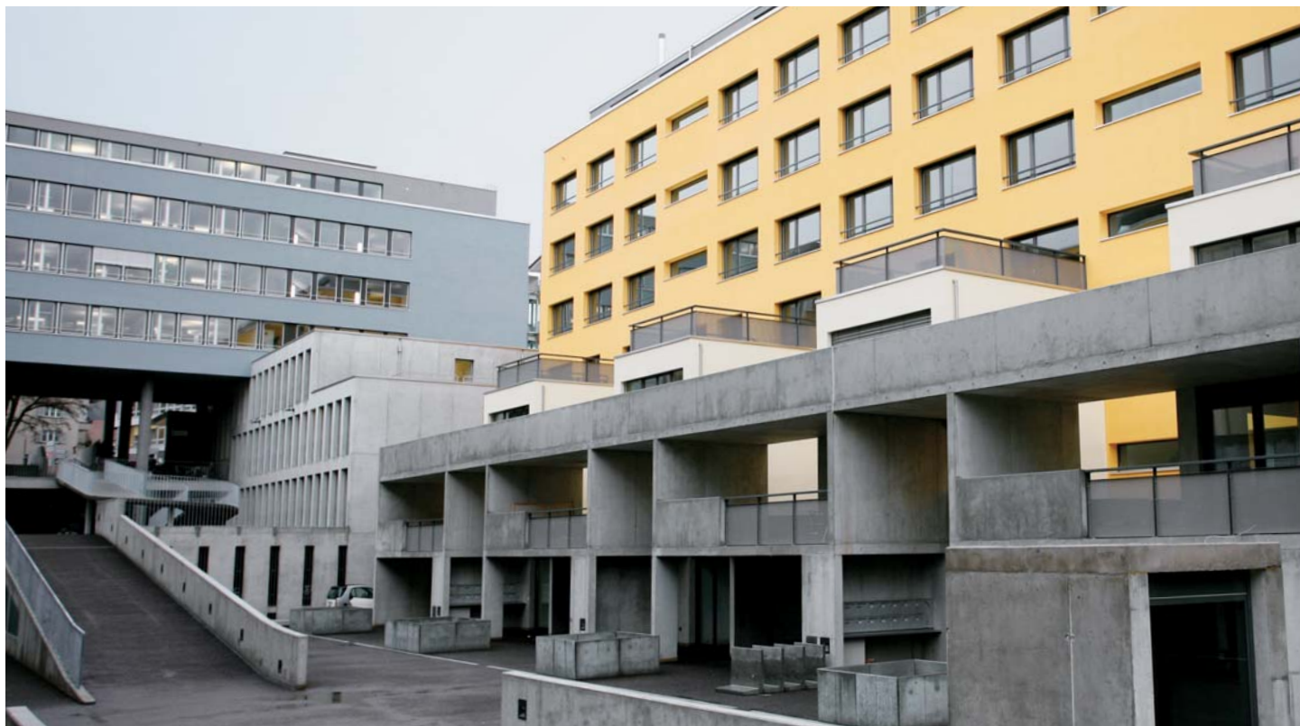
Scheuerrain avec l'immeuble administratif de PUBLICA (bleu), l'un des deux immeubles d'habitation (jaune) et les auvents encore exempts de verdure (gris)
